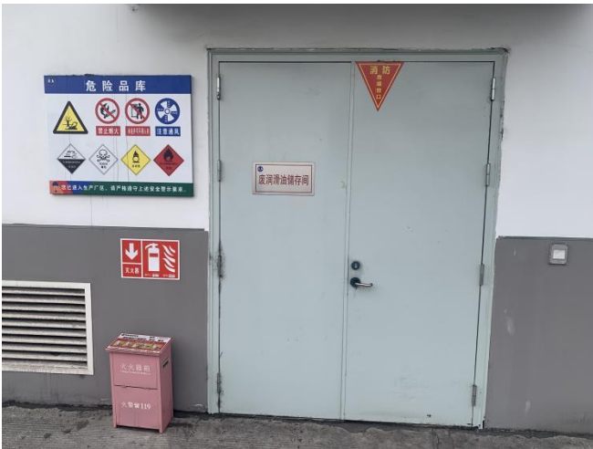
危险废物暂存间
