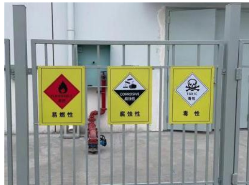
危险废物暂存间标识
