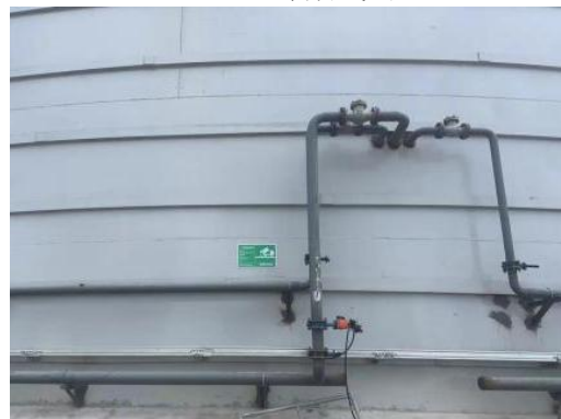
一般固废暂存间标识 (灰库)
