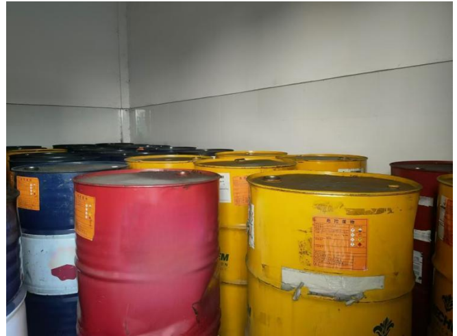
危险废物暂存间内部
